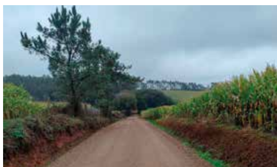
Melloramos a pista Os Canedos-San Nicolao, con limpeza de cunetas e zavorra
