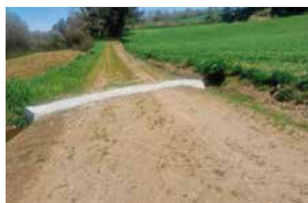
Arranxamos as cunetas e colocamos unha taxeia en Caboladrón
