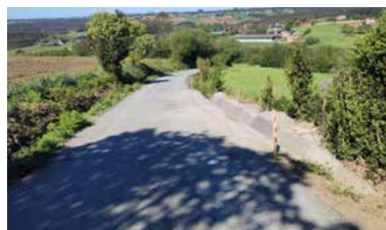
Tramo de cuneta arranxado en Filgueira
